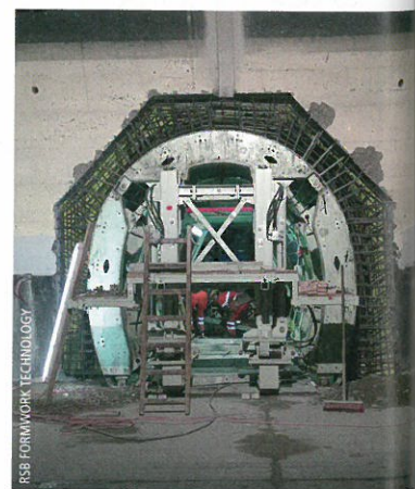
Querschlagschalung für den Oswaldibergtunnel in Villach (Kärnten).
