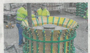
Die Vorarlberger Firma hat die Schalung der Betonkugel geliefert.
